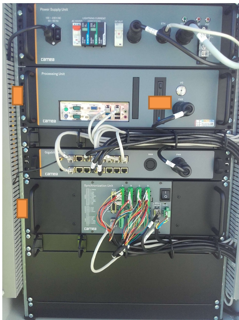
Obr. 6 Rozvodňa UC-CAB s komponentami UnicamSPEED-R (UC-PSU, UC-CPU, UC-ESU, UC-SIU, UC-SU), oranžové obdĺžniky sú vyznačené miesta pre overovacie značky
