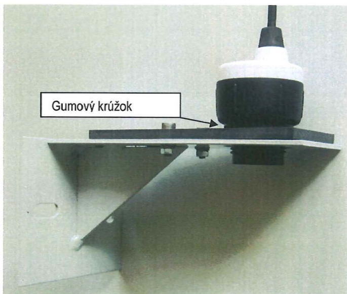
Obr. č. 5 Držiak so senzorom výšky hladiny Echopod
